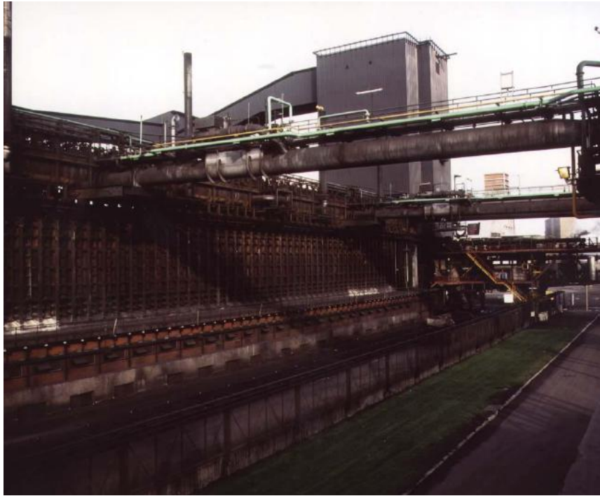
Şekil 6.1 : Bir kok fırını tesisinin hazneler, kömür kulesi ve kok fırını gaz toplama hattının resmi.
