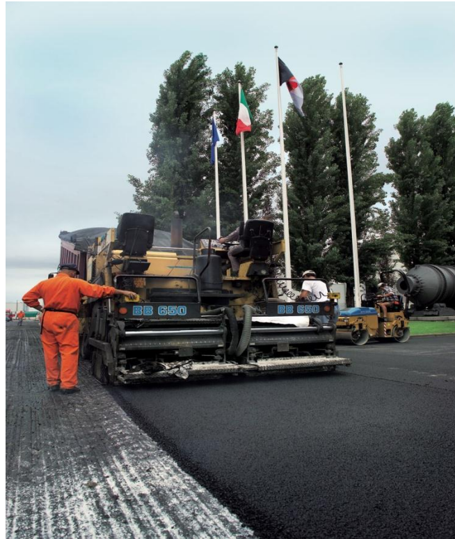
Şekil 2.4: Cürufun Asfalt Malzemesi Olarak Kullanımı
