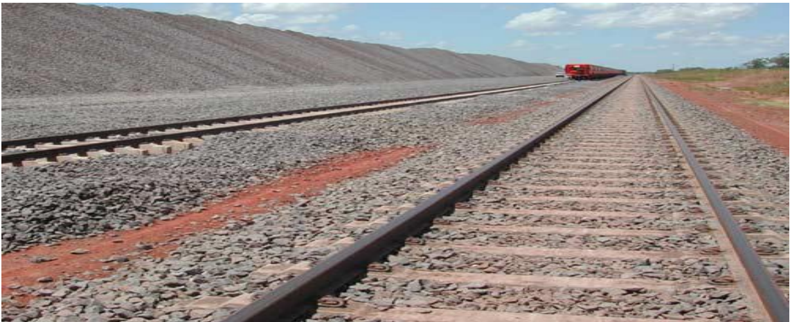
Şekil 2.5: Cürufun Demiryolu Balastı Olarak Kullanımı
