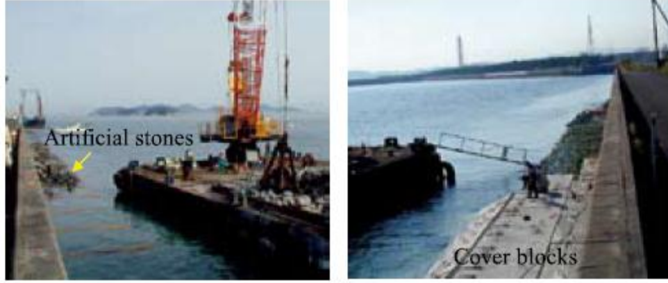
Şekil 2.6: Japonya’da EAF Cürufunun Limanda Agrega Olarak Kullanımı
