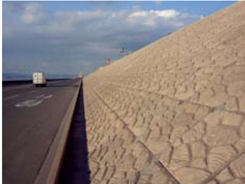
Şekil 2.7: Japonya Mizushima limanında Ferroform kullanılarak yapılan deniz duvarları.
