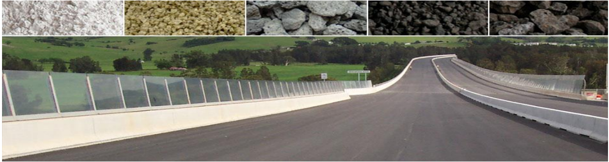
Şekil 2.3: Üstyapısında Cüruf Kullanılmış Yol Görünümü
